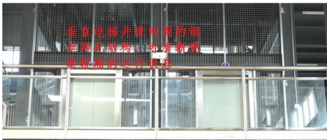
图 7 垂直电梯井道四周焊接的钢丝网孔
